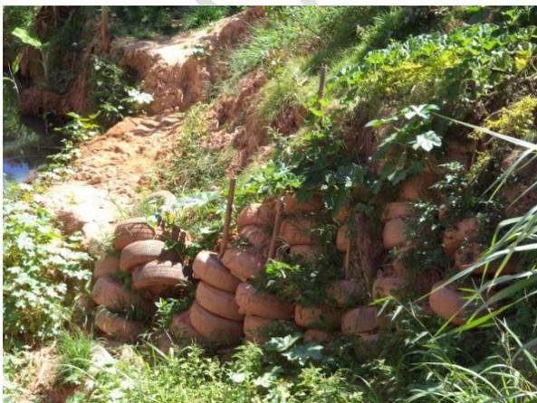
FIGURA 26 – UTILIZAÇÃO DE PNEUS NA CONTENÇÃO DE BARREIRAS (VISTA 1) (FONTE: ACERVO DO AUTOR, 2014)
