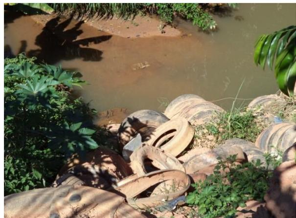
FIGURA 27 – UTILIZAÇÃO DE PNEUS NA CONTENÇÃO DE BARREIRAS (VISTA 2) (FONTE: ACERVO DO AUTOR, 2014)
